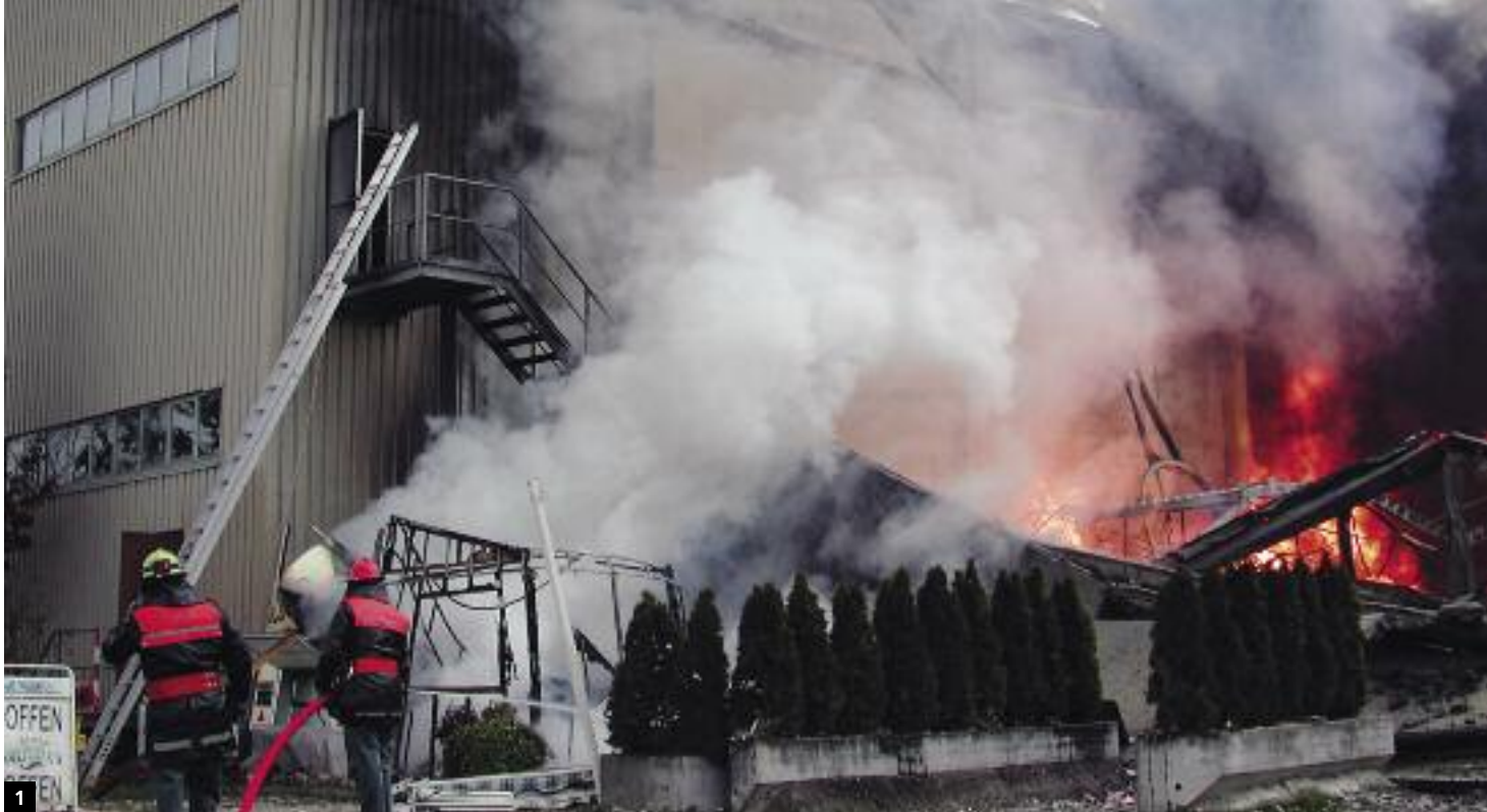
1 Verwoestende brandschade wordt dikwijls veroorzaakt door vuurverspreiding via gevel en dak
