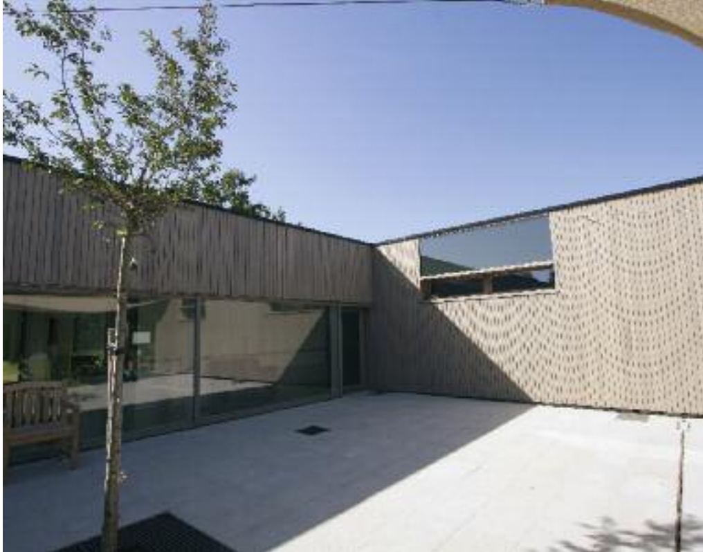
Geventileerde gevel, houten bekleding
